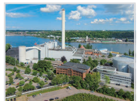
Bild 1. Blick auf das zentrale Heizkraftwerk an der Flensburger Förde.
